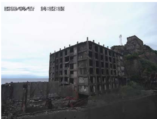
図7 日本最古の鉄筋 コンクリート造集合住宅 30号棟
